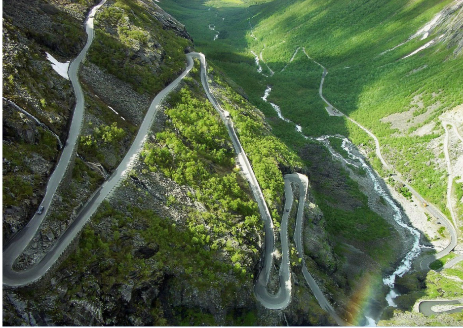
شكل 1.1: إذا كان طريقنا نحو الشمال فإن هذا لا يمنع وجود أجزاء في الطريق تكون في الاتجاه المناقض (أي الجنوب). طريق في النرويج. المرجع: medium.
